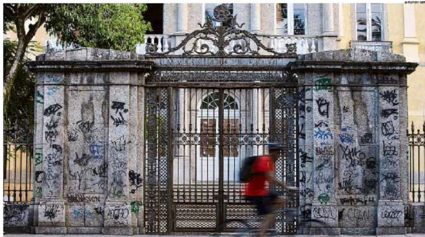
Abandono. Um dos portais da UFRJ no complexo Praa Vermelha, universidade que administra o Museu Nacional, que sofreu um grave acidente no último mês de agosto e a falta de manutenção e foi destruído no último domingo por um incêndio
